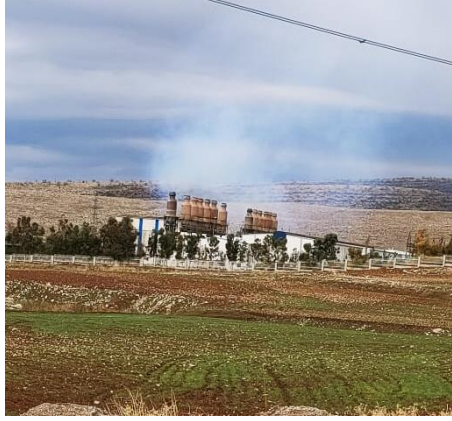
صورة (3) تلوث الهواء لمحطة الكهربائية في باعدرى
